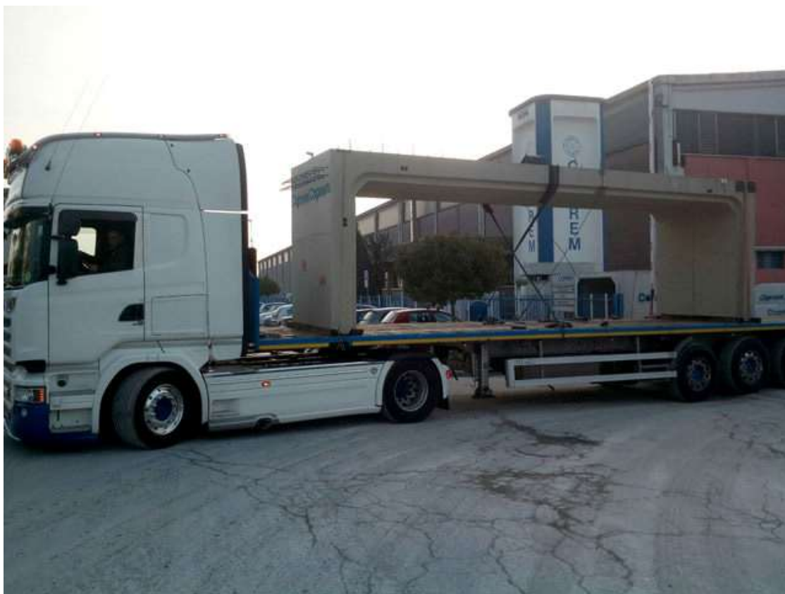
Figura 7.2. Trasporto di un manufatto scatolare prefabbricato
